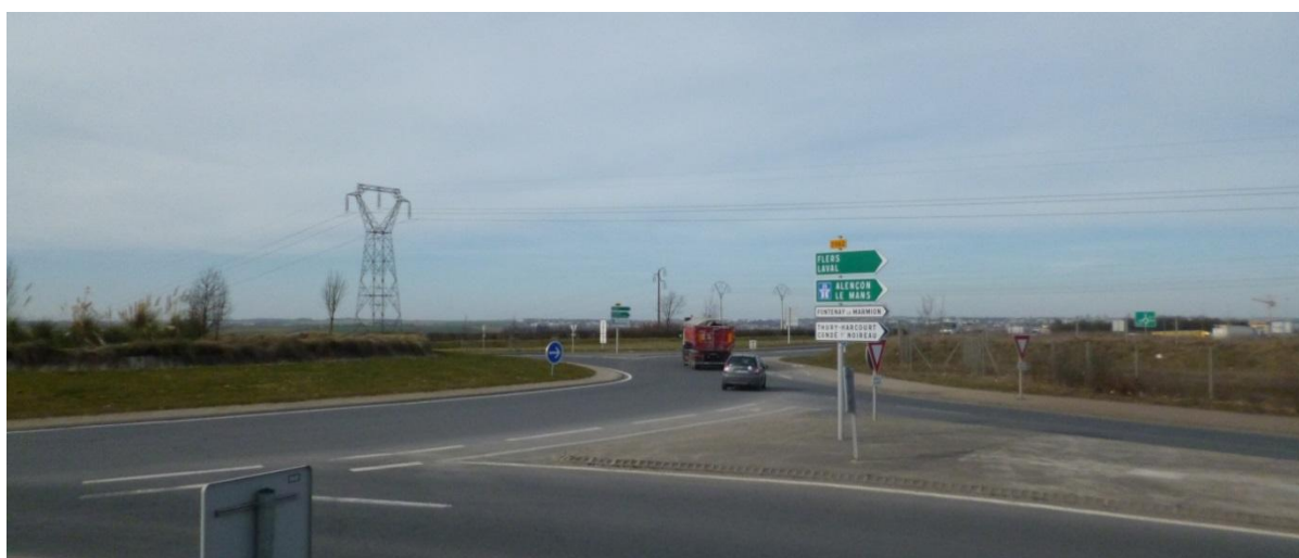
Figure 14 - Vue sur le giratoire RD 562 / RD 562A
