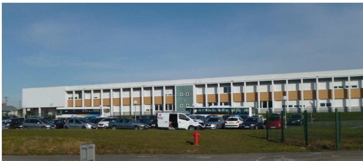
Figure 10 - Le collège Guy de Maupassant
